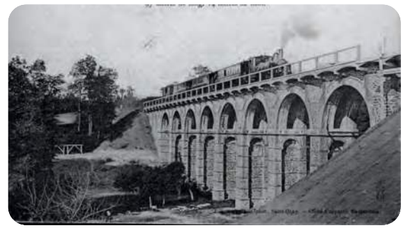
Das ehemalige Ponto-Viadukt
