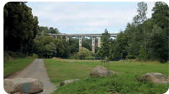
Die Toupin-Brücke in Saint-Brieuc wird auch heute noch genutzt
