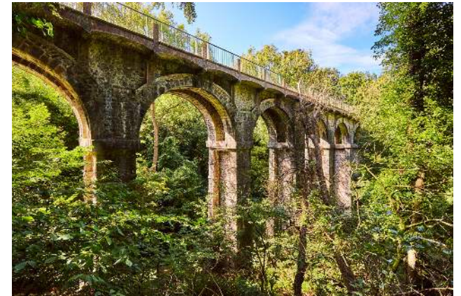
Le viaduc des Pourrhis.
