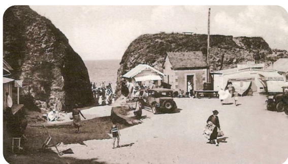
Passage de l'Avant-Port
